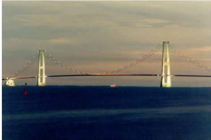
Der tiefste Punkt des Kabels zwischen den beiden Pfeilerspitzen liegt ca. 3m über der Fahrbahn.
